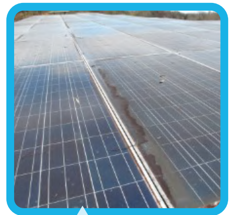
発電量下落要因のひとつ、太陽光パネルの汚れ
